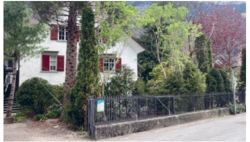
Westfassade nach Abbruch 2022
