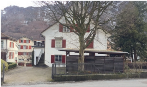
Westfassade vor Abbruch 2020
